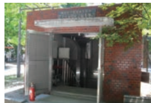
鶴巻南公園応急給水槽
